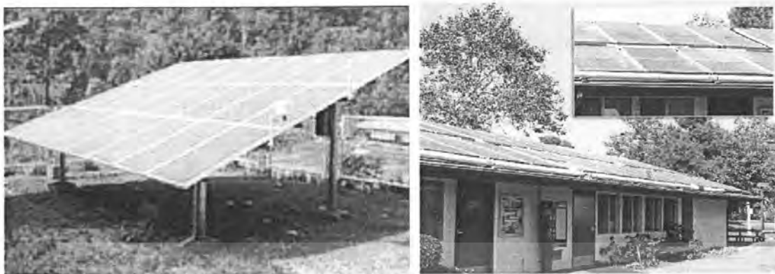
รูปที่ 24 แสดงตัวอย่างแผงเซลล์ที่ตั้งอยู่กับที่
