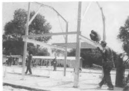
ภาพที่ 2.39 แสดงการประกอบแผงวางพื้นห้อง
