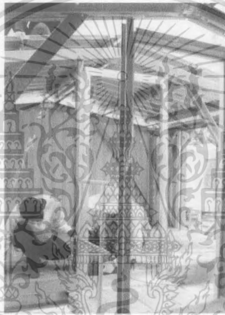
ภาพที่ 2.66 แสดงการประกอบกรอบประตูกับ โครงสร้าง
