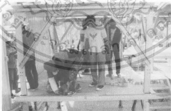
ภาพที่2.57 แสดงการขีดตำแหน่งสำหรับติดตั้งเสาหน้าต่าง
