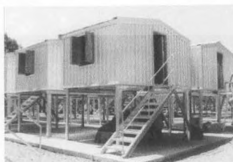
ภาพที่ 2.87 แสดงการประกอบติดตั้งบ้านพักฉุกเฉินที่เสร็จเรียบร้อยแล้ว
