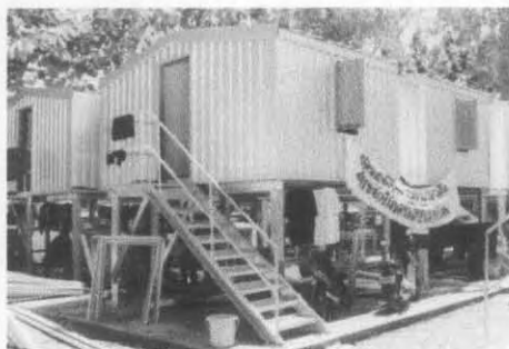
ภาพที่ 2.84 แสดงการติดตั้งประตูเสร็จแล้ว
