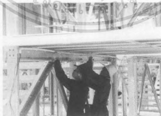
ภาพที่ 2.67 แสดงการติดตั้งสายไฟ
