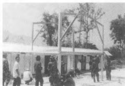
ภาพที่ 2.37 แสดงการยึดตัวฐานรากกับ โครงเสา
