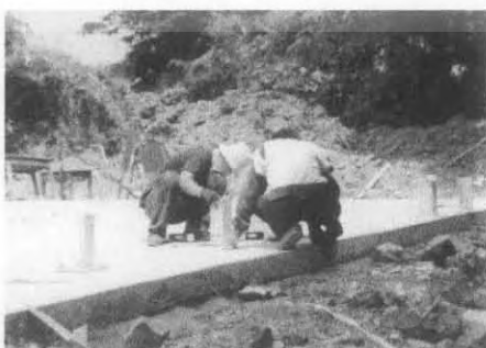
ภาพที่ 2.30 แสดง ภาพฐานรากที่จะนำมาประกอบกับเสาเข็ม
