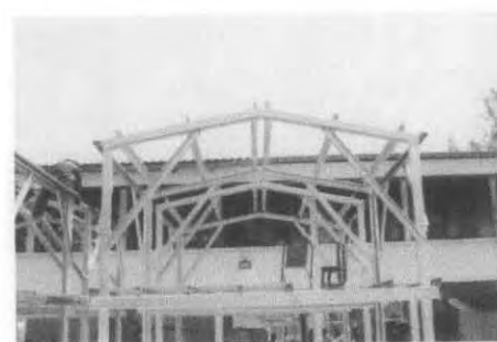
ภาพที่ 2.41 แสดงการประกอบส่วนค้ำหลังคา
