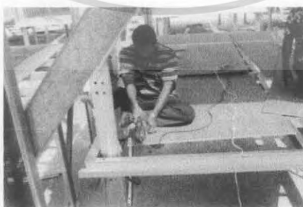
ภาพที่2.54 แสดงการตัดแต่งแผ่นไม้เพื่อให้เข้ากับขนาดของพื้นที่
