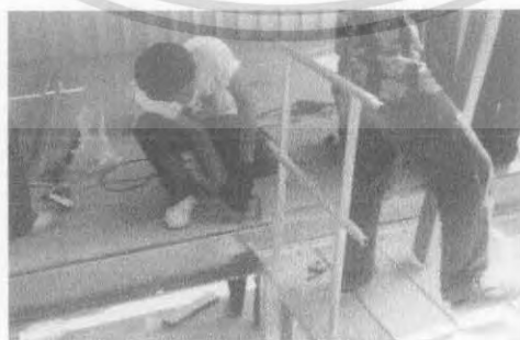
ภาพที่ 2.61 แสดงการยึดตำแหน่งสำหรับติดตั้งเสาประตู
