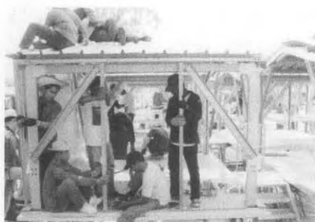
ภาพที่ 2.58 แสดงการติดตั้งเสาเพื่อติดหน้าต่าง
