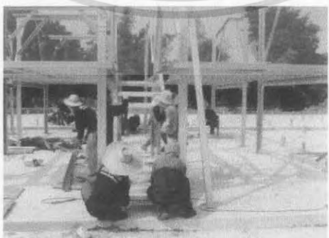
ภาพที่2.50 แสดงการติดตั้งบันได
