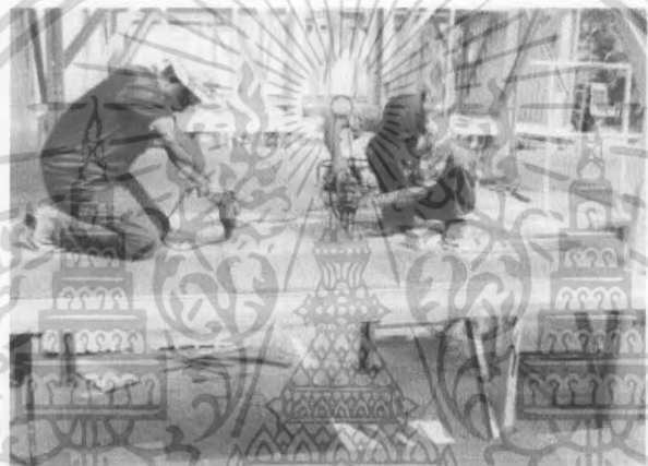
ภาพที่2.56 แสดงการขีดแผ่นไม้กับตัวโครงสร้าง
