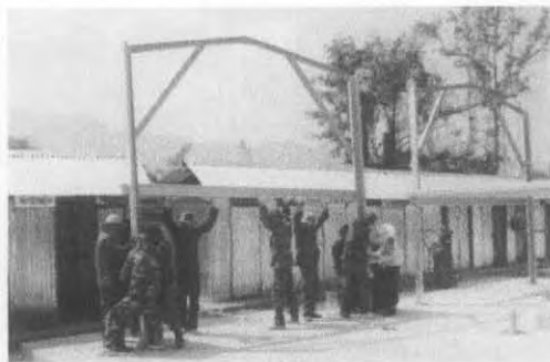
ภาพที่ 2.35 แสดงการยกตัว โครงเสาขึ้นเพื่อยึดกับฐานราก 1
