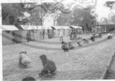
ภาพที่ 2.23 แสดงการตรึงเส้นเอ็นเป็นแนวเพื่อการวางฐาน
