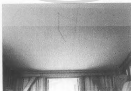
ภาพที่2.83 แสดงการติดตั้งฝ้าภายในห้องพักเมื่อเสร็จแล้ว
