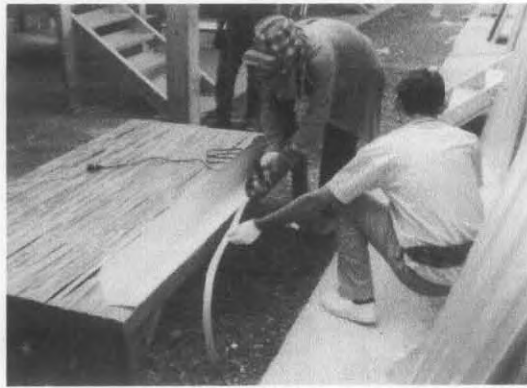
ภาพที่ 2.74 แสดงการตัดลูมึนเนียมจากเพื่อปิดกรอบมุงของบ้าน
