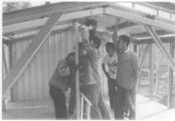
ภาพที่ 2.62 แสดงการติดตั้งเสาเพื่อติดกรอบประตู
