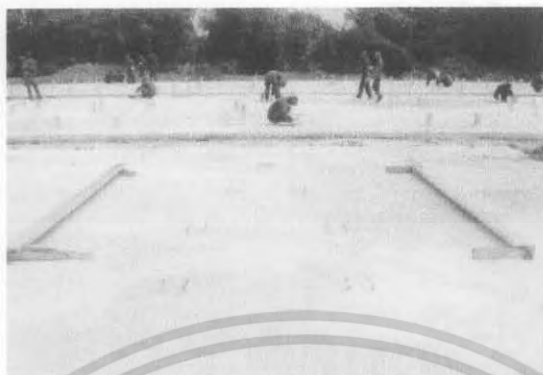
ภาพที่ 2.32 แสดงการวางโครงของเสาบ้านในแนวนอนเพื่อทำการประกอบ โดยจะอยู่บริเวณของบ้านหลังนั้น
