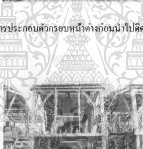
ภาพที่ 2.60 แสดงการนำกรอบหน้าต่างไปประกอบกับโครงสร้าง
