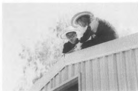
ภาพที่2.80 แสดงการติดตั้งอูมเนียมแผ่นปิดร่องเพื่อกันฝน
