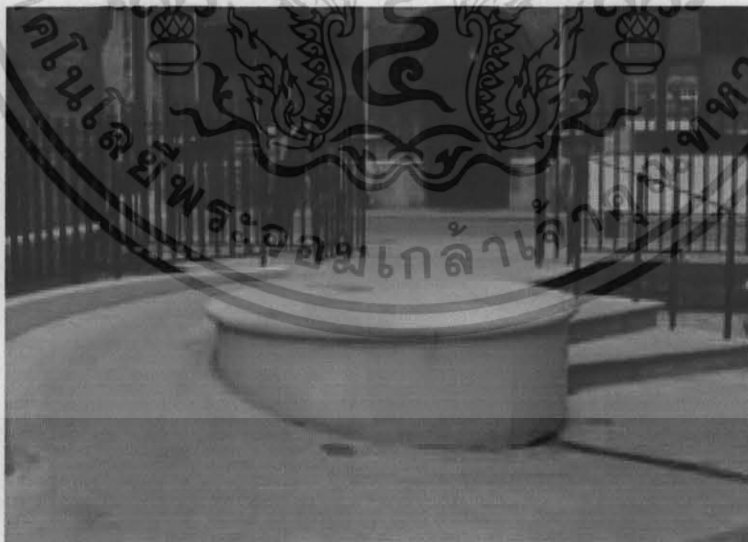
ภาพที่ 3.27 แสดงทางลาดเข้าอาคารสำหรับรถเข็น
