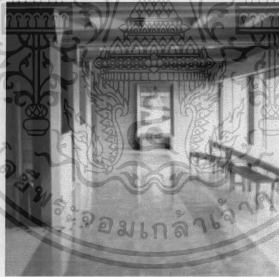
ภาพที่ 3.11 แสดงการปูกระเบื้องยางเพื่อเป็นแนวการสัญจร
