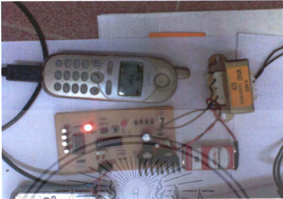
รูปที่ 4.8 แสดงเครื่องส่งเมื่อไฟฟ้าดับ
