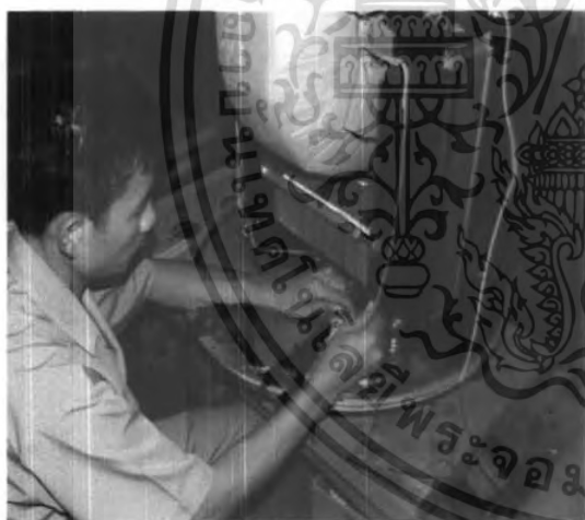
รูปที่ 5.56 การต่อสายกราวด์
