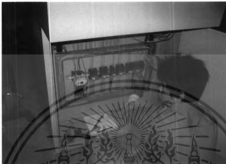
รูปที่ 5.74 ทำการประกอบแผงวงจรเข้ากับตู้
