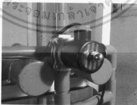
รูปที่ 3.15 ติดตั้งระบบควบคุมวาล์วไฟฟ้า (โซลินอยด์วาล์ว)
