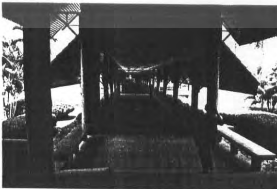
รูปที่ 6.2.1.6 จากอาคารส่วนต้อนรับ ด้านหน้าสู่ อาคารหลักที่เป็น ส่วนแสดงความรู้ต่างๆ โดยเดิน ผ่านระเบียงที่มีหลังคาคลุมต่างระดับทางเดินมีขนาดกว้างขวาง
