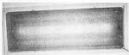
รูปที่ 2.2-4 โคมไฟฟ้าหลอด ฟลูออเรสเซนต์ 36 วัตต์ หรือ 18 วัตต์
