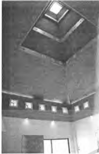
รูปที่ 2-28 Skylight บริเวณโถง
