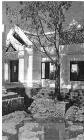
รูปที่ 2-17 บริเวณบ่อน้ำเดิม
