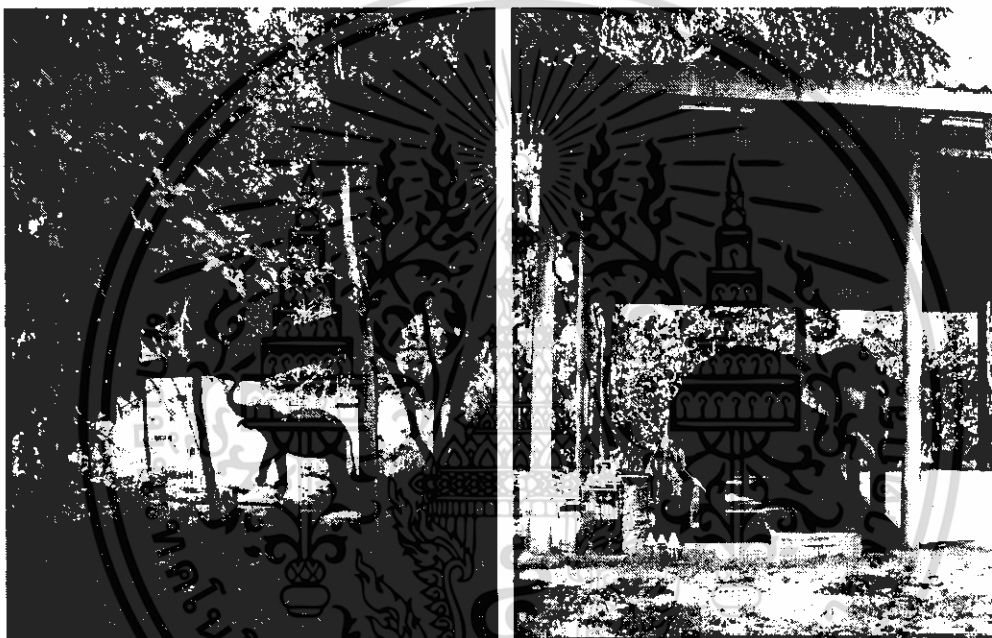
รูปที่ 7.14 คอกช้างควรมีความสูงอย่างน้อย 6 เมตร เพราะช้างสามารถเอางวงดึงคานเล่นและจะทำให้โครงสร้างเสียหายอันจะนำมาสู่เสียหายแก่ช้างและคนได้
