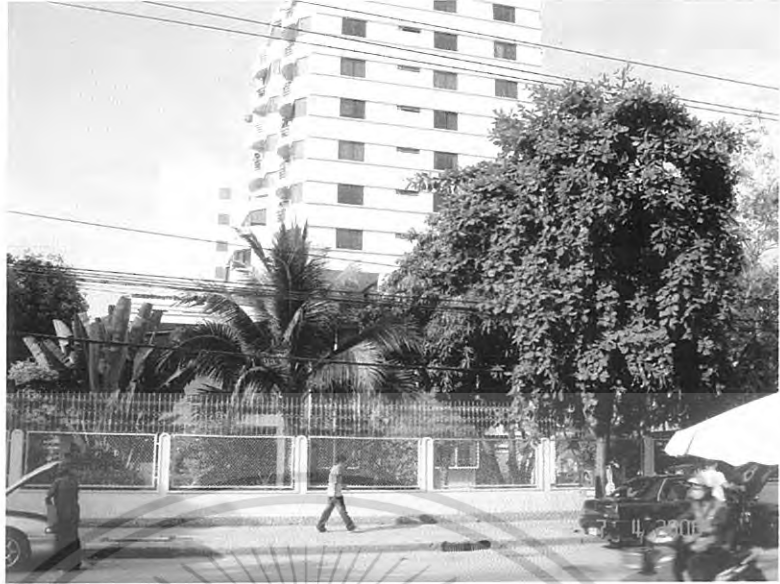
ภาพที่ 3.16 ตัดกับถนนรางน้ำ ซอยวัดน โยธิน ชุมชนพักอาศัย ตึกสายธาร
