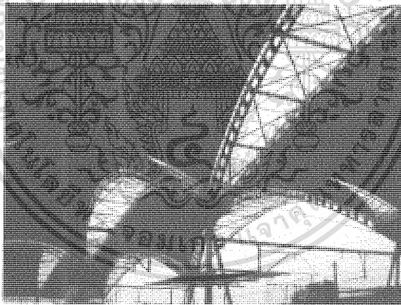
รูปที่ 5.32 รูปแสดงเสา Pylon เหล็กที่กลมสามขารองรับส่วนปลายของหลังคาโค้ง 4 มุม
