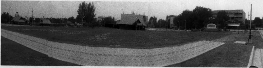
ภาพที่ 2.7 แสดงสภาพโดยรอบของบริเวณสถานที่ก่อสร้างโครงการอาคารเรียน และปฏิบัติการคณะการแพทย์แผนไทย
