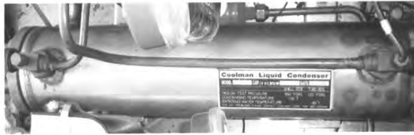
รูปที่ 3-3 แสดงคอนเดนเซอร์ชนิดเปลือกและท่อ
