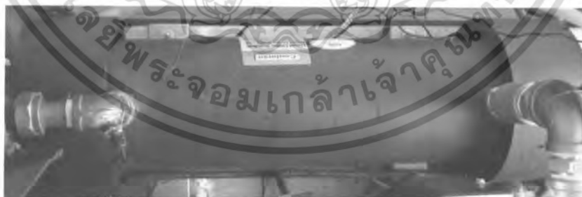
รูปที่ 3-2 เครื่องระเหยแบบใช้ของเหลวทำความเย็นชนิดเปลือกและท่อ
