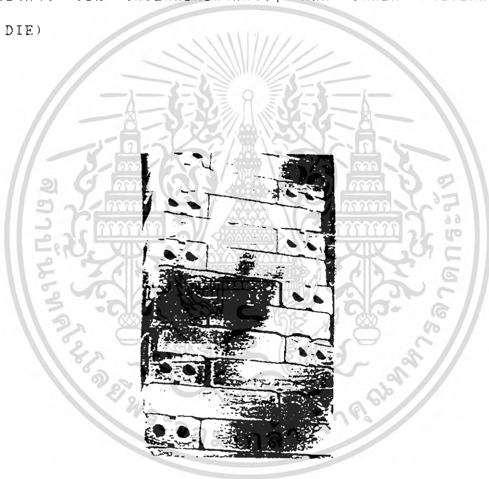
ภาพที่ 111. ภาพแสดงอิฐที่ขึ้นรูปด้วยวิธีผ่านเครื่องรีด
