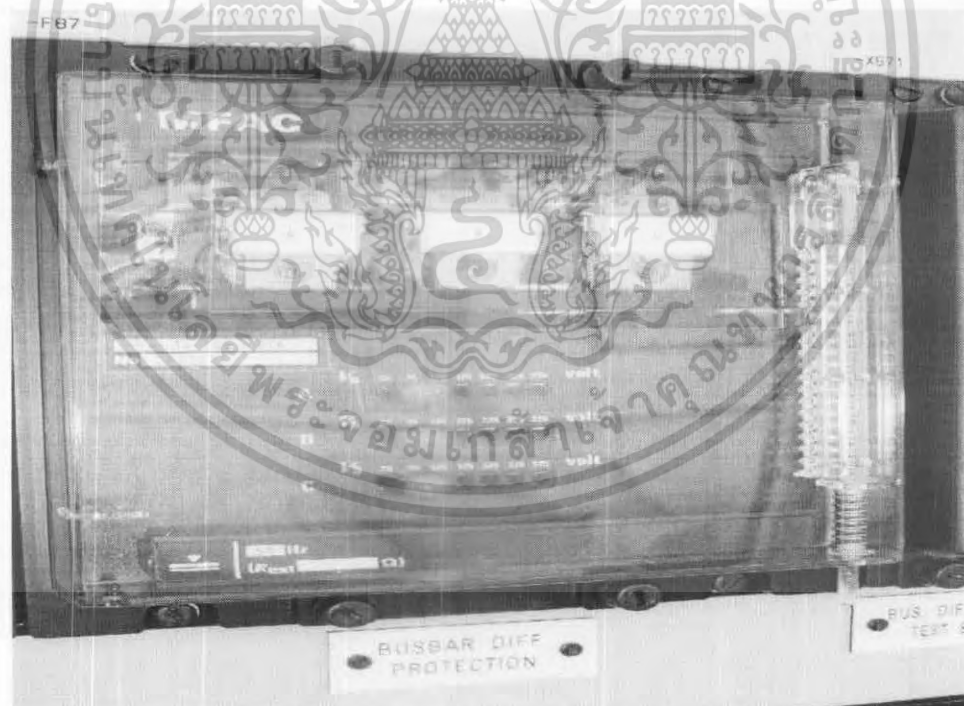
รูปที่ 12 แสดงดิฟเฟอร์เรนเชียลรีเลย์แบบโซลิมพ็อดนซ์ ที่ใช้ป้องกันบัสบาร์
