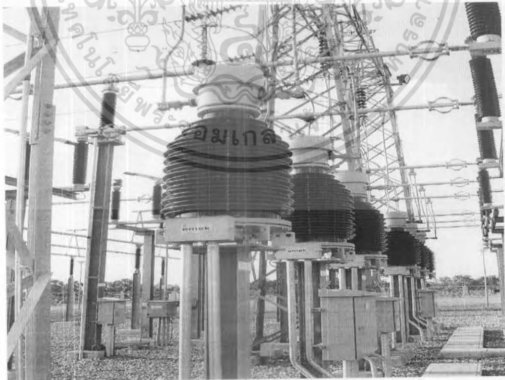
รูปที่ 12 แสดงซีทีที่ติดตั้งอยู่ในลานไกไฟฟ้า
