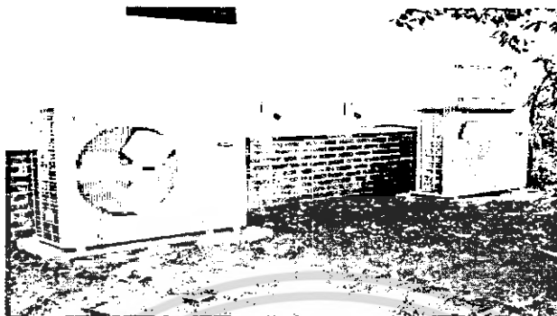
รูปที่ 2.7 คอนเดนเซอร์แบบมีพัดลมช่วย
