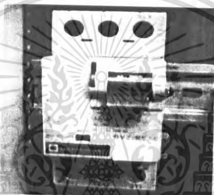
รูปที่ 3.6 Power circuit breaker
