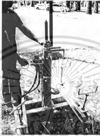
รูป ข-22 การดึงก้านกดขึ้นโดยใช้ตัวจับยึดถอนก้านกด
