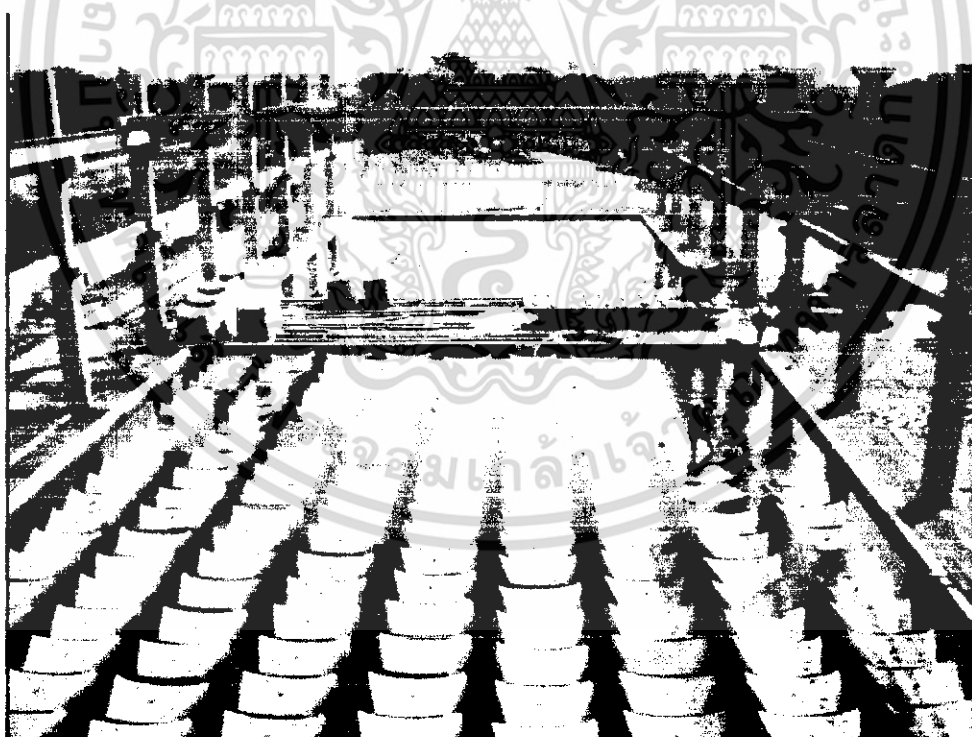
รูปที่ 5.37 การบ่มชิ้นส่วนประกอบผนังอุโมงค์
