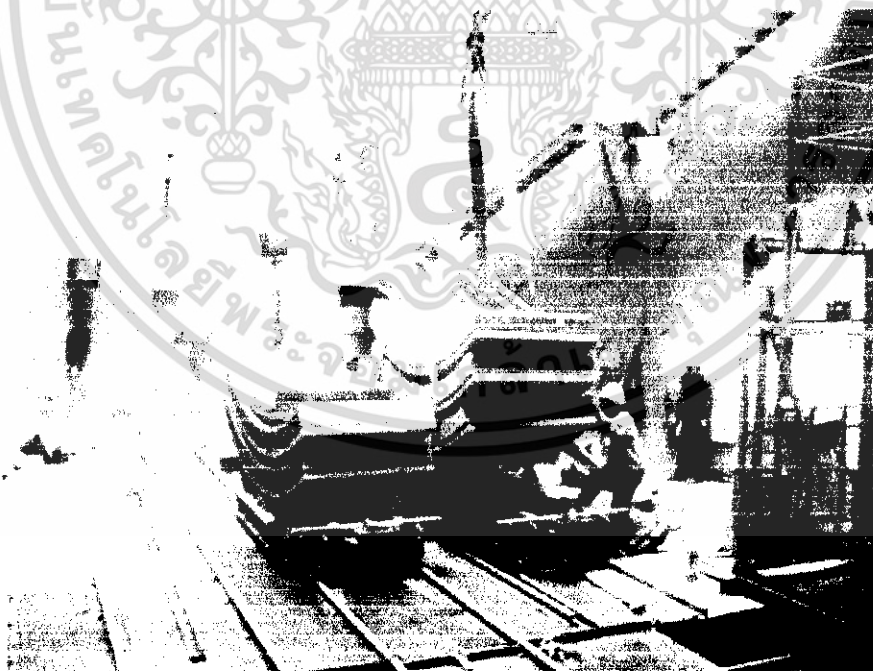
รูปที่ 6.46 การขนย้ายชิ้นส่วนประกอบผนังอุโมงค์
