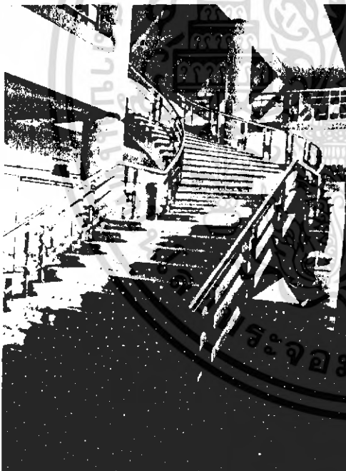
ภาพที่ 3.4 แสดงโถงบันไดขึ้นสู่ชั้นที่ 2
