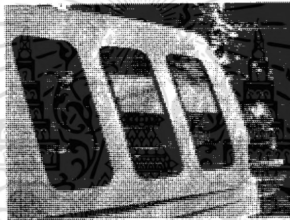
ภาพที่ 2.1.5-6 แสดงบริเวณหน้าต่างด้านข้างของโรงไฟฟ้าวิศวกรรมมหาวิทาลัยศรีเชียงใหม่ เป็นแบบบานเลื่อนเปิดขึ้นลง
