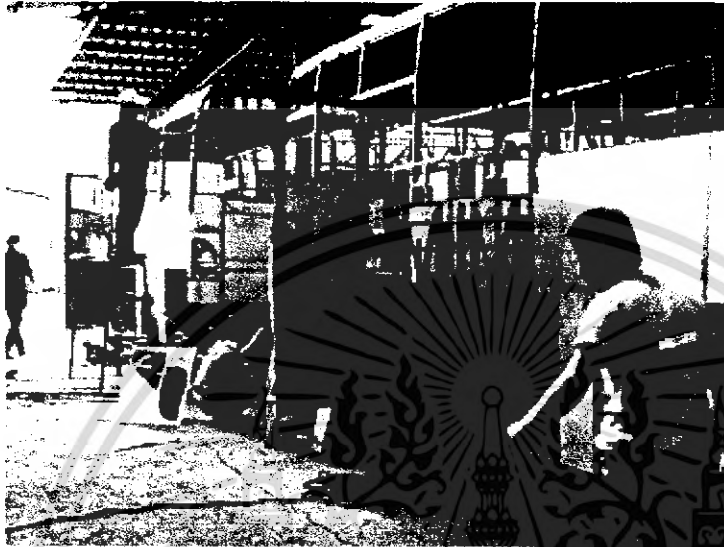
2.91 ภาพการประกอบแผ่นโลหะกับโครงหลังคา
