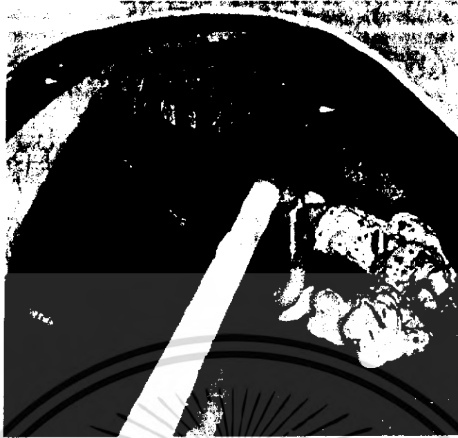
รูปที่ 3.11 การฉีดโฟมอินทรีย์
