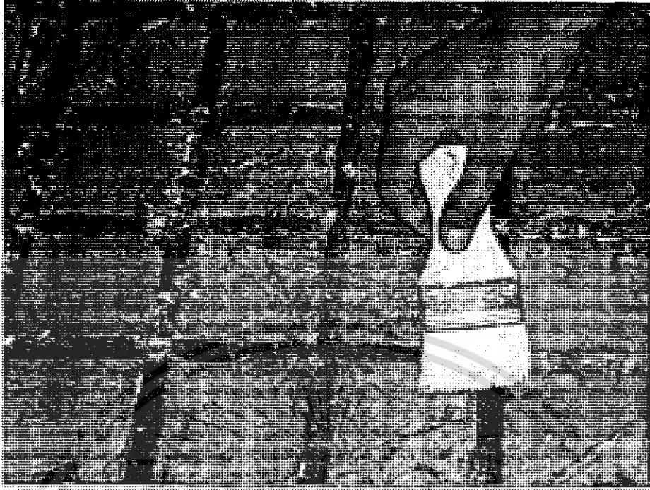
รูปที่ 3.28. แสดงการเสริมค้ำข่ายเส้นใยคาร์บอนด้านนอกฉาบด้วยอิพอกซี
