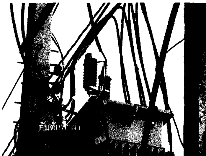
รูปที่ 2.6 การติดตั้งกั๊บดักฟ้าผ่าที่ใช้งานในระบบจำหน่ายร่วมกับหม้อแปลงไฟฟ้า
