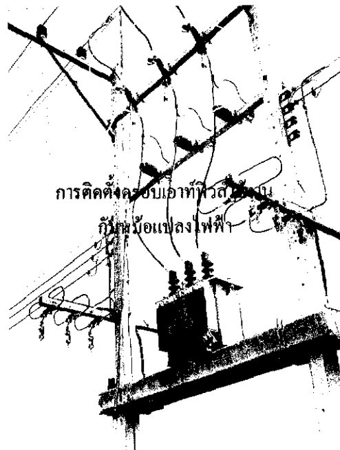
รูปที่ 2.2 การติดตั้งครอบเอาต์ฟิวส์ที่ใช้งานในระบบไฟฟ้า
