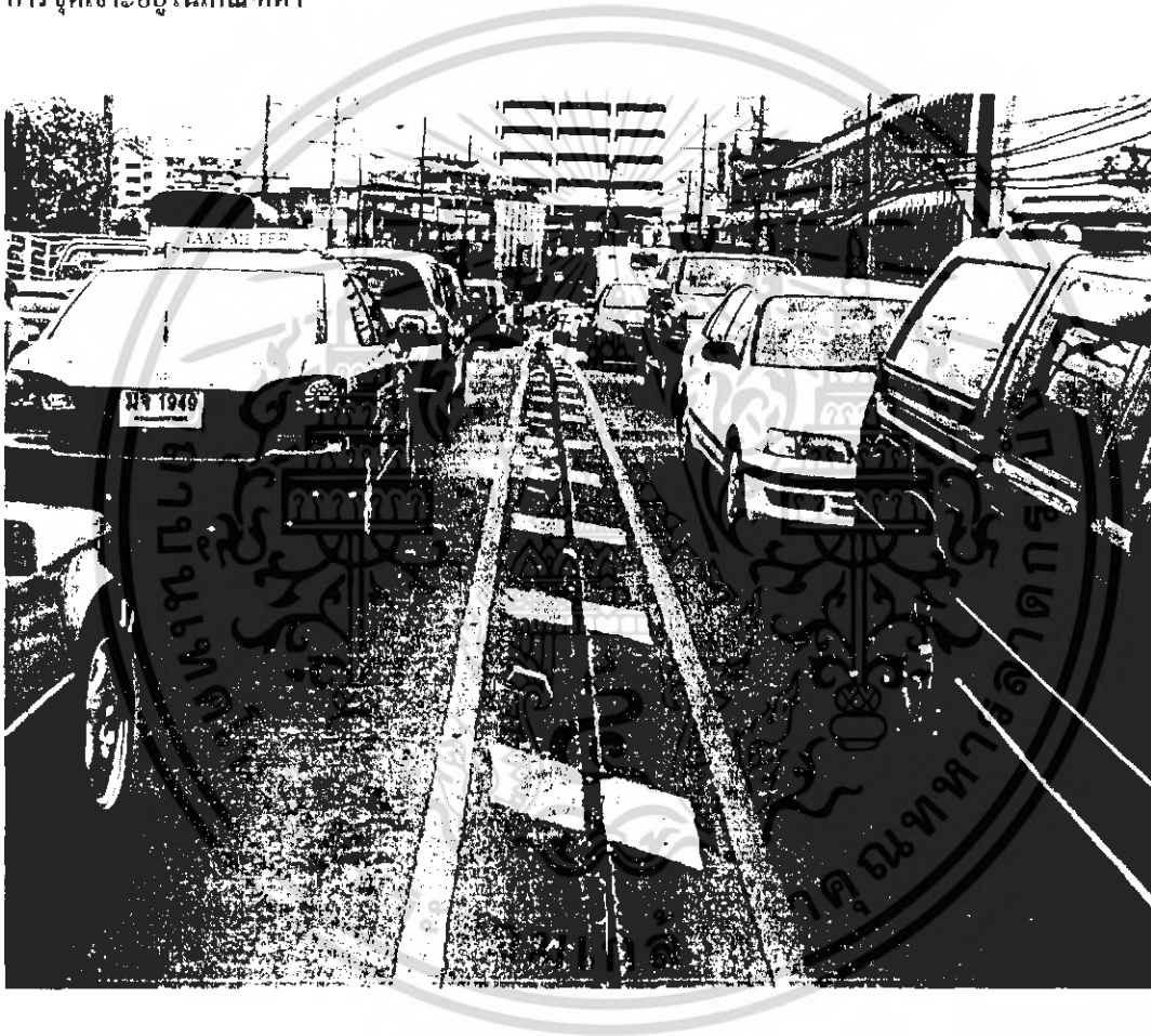
รูปที่ 7.2 รอยแยกตามแนวรอยต่อ Movement Joint
