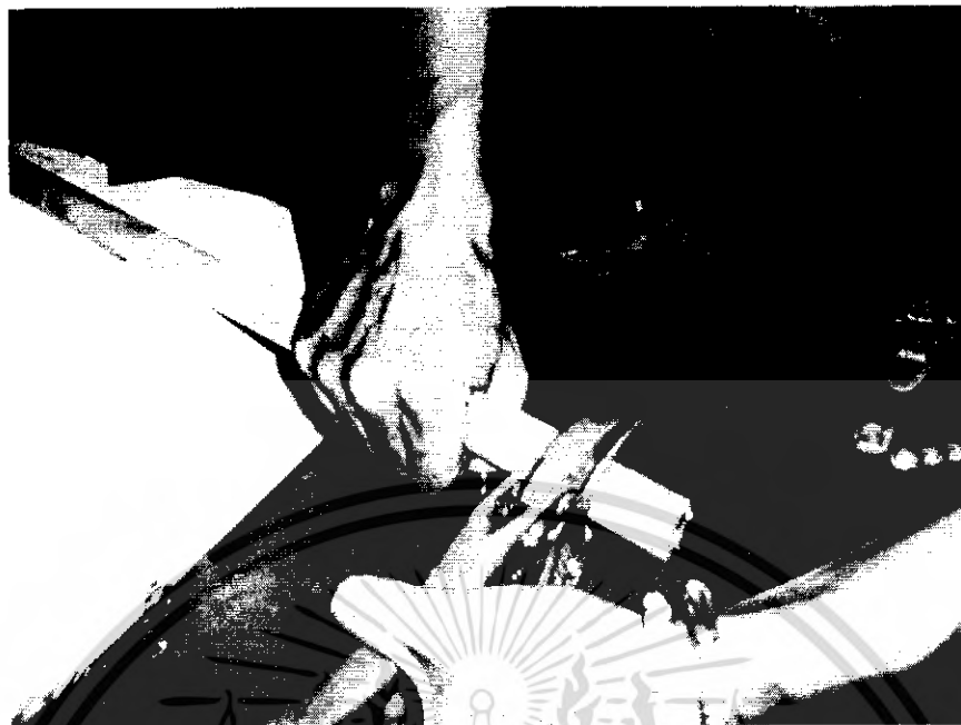
รูปที่ 4.6 ทำการปลอกชั้นฉนวน XLPE และ ตัวนำ
