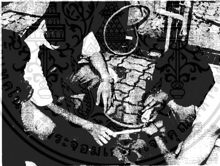
รูปที่ 3.22 การอุดรอยรั่วของท่อ
