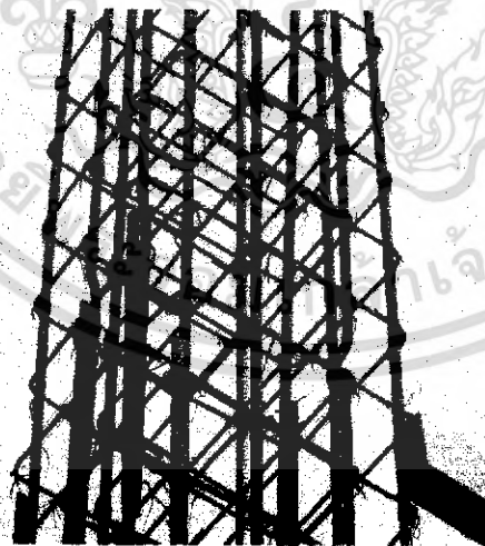
รูปที่ 1.1 ภาพการเชื่อมต่อของเหล็กข้ออ้อยโดยการมัดควด
