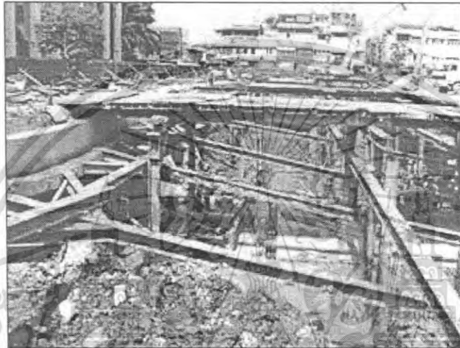
รูปที่ 8.8. การนำกองดิน (Berm) ช่วยในการค้ำยัน
