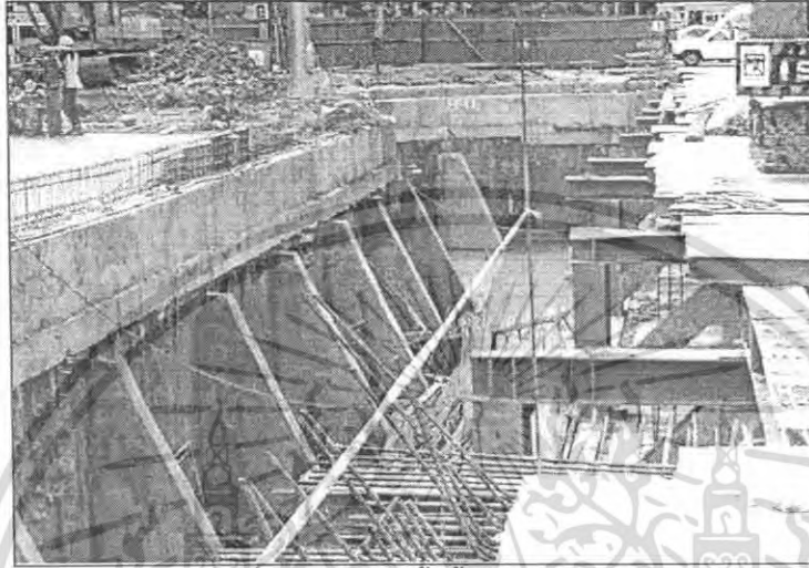
รูปที่ 8.5. การติดตั้งค้ำยันแบบครีป
