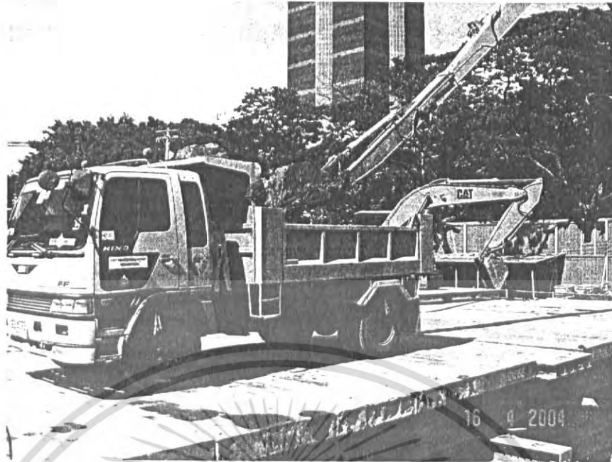
รูปที่ 6.19 Dump Truck 6 Well
