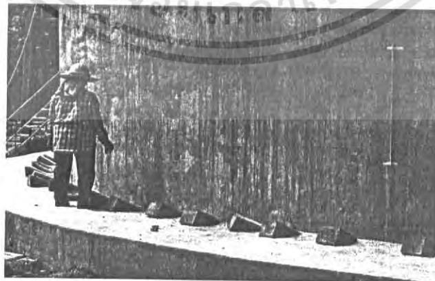
รูปที่ 8.6 การเตรียมลิ่มไม้เพื่อหยุดการจมของสัจ
