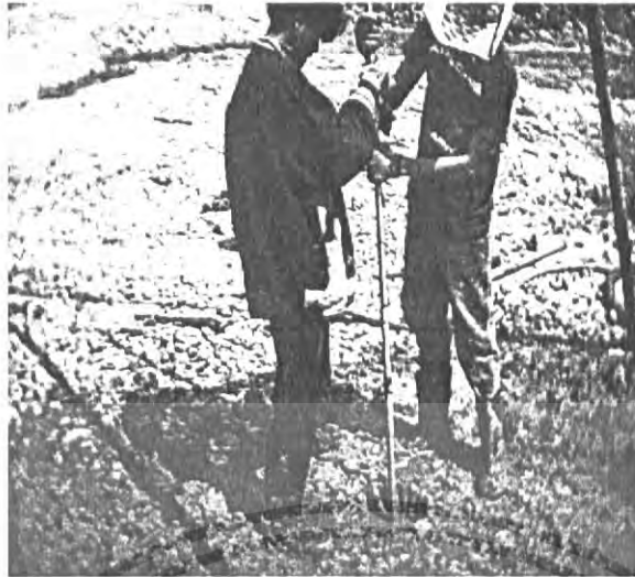
รูปที่ 7.3 การติดตั้ง Piezometer
