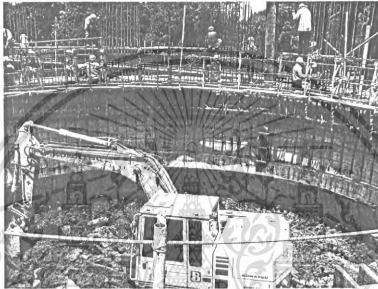
รูปที่ 6.12 การชูดดินภายในเคของส์
