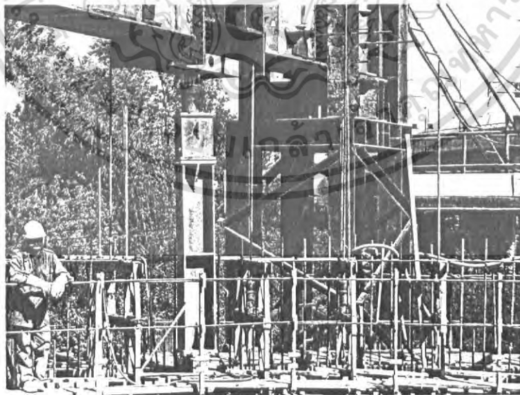
รูปที่ 6.13 การจมเคของส์โดย Hydraulic Jack
