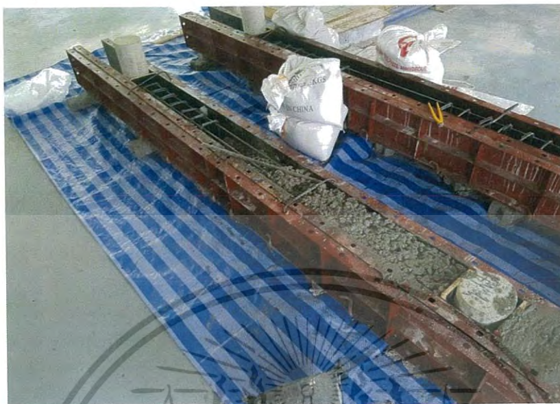
รูปที่ 3.5 เทคอนกรีตลงแบบหล่อ
