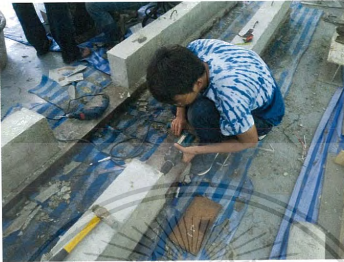
รูปที่ 3.8 เจาะรูสำหรับติดตั้งแผ่นเหล็กที่ปลายคาน
