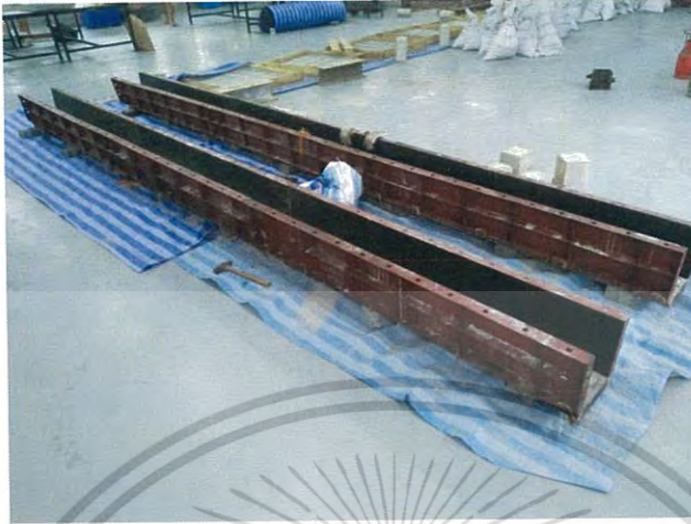
รูปที่ 3.1 ประกอบแบบหล่อคอนกรีต
