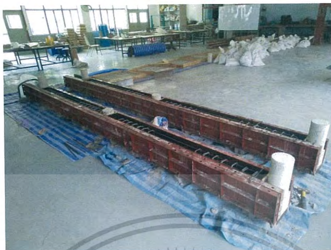
รูปที่ 3.3 เหล็กเสริมเมื่อนำมาใส่แบบหล่อคอนกรีตแล้ว
