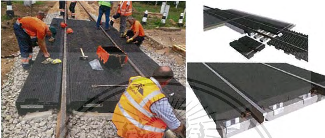
รูปที่ 2.15 ตัวอย่างแผ่นยางปูทางผ่านเสมาระดับทางรถไฟของบริษัท Trelleborg [23]
