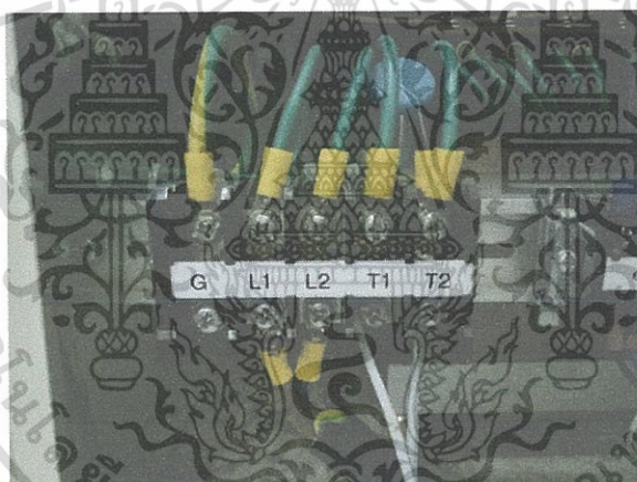
รูปที่ 3. 3 แสดงตำแหน่งของสาย T1, T2 ของเครื่องเอกซเรย์
