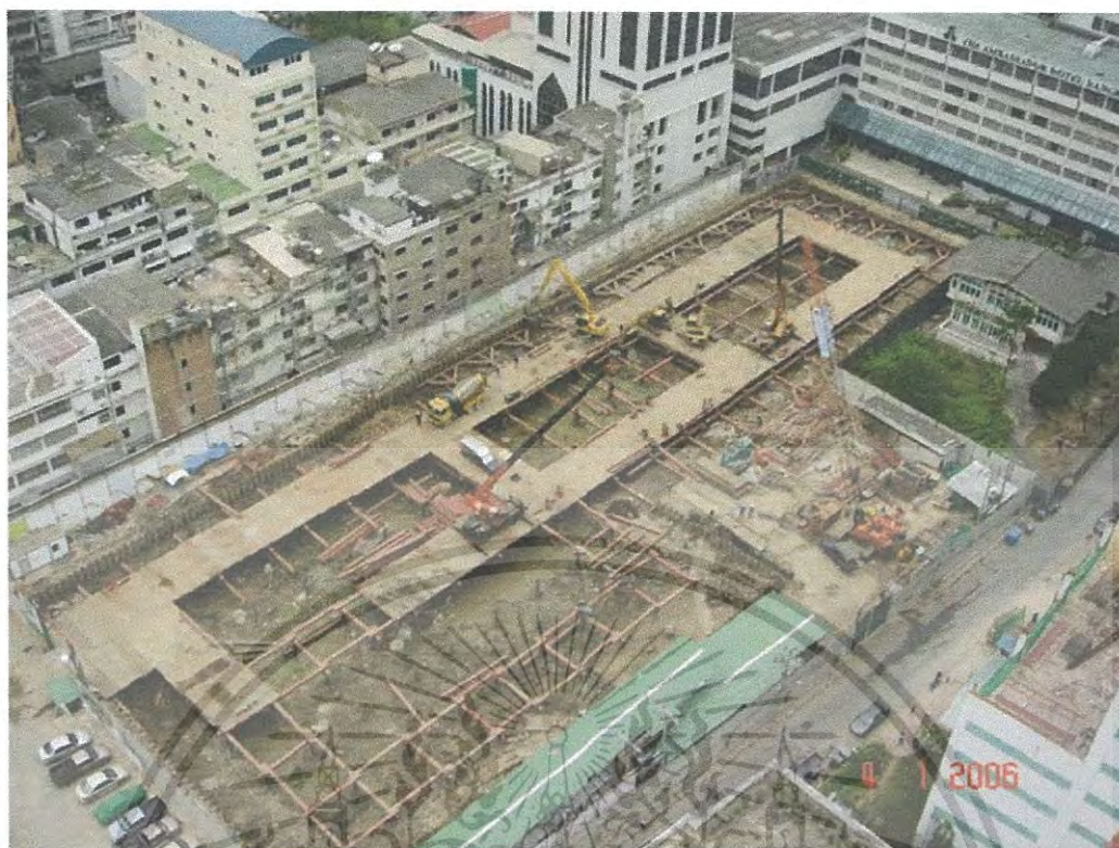
รูปที่ 2.17 งานติดตั้งสะพาน
