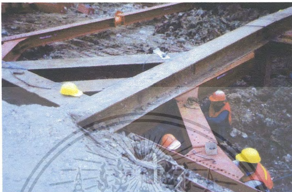
รูปที่ 2.20 การติดตั้ง Strut เข้ากับ Wale ยึดต่อกันด้วย Angle Reinforcement 60 องศา
