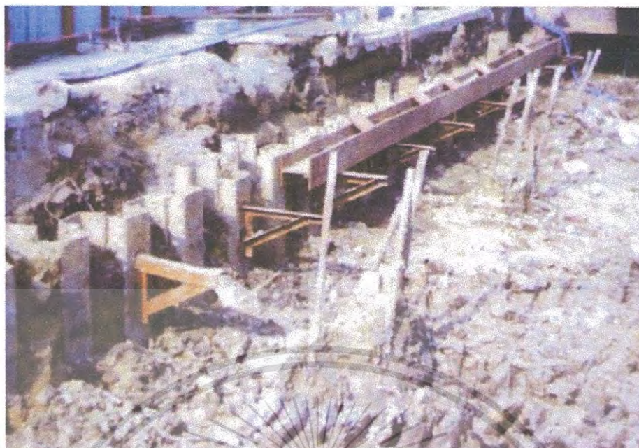
รูปที่ 2.18 การติดตั้ง Bracket และ Wale
