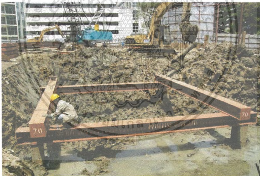
รูปที่ 2.16 งานติดตั้ง Floor Joist Beam
