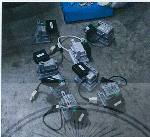
รูปที่ 2.31 การติดตั้งวงจรภาคส่งกับโหลดแอลอีดีขนาด 15 วัตต์
