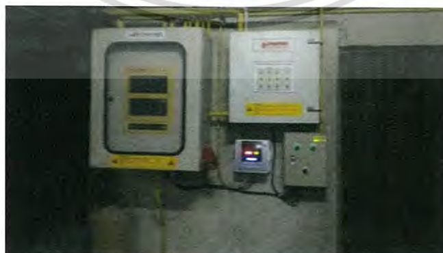
รูป 2.3 เครื่องควบคุมอุณหภูมิภายในโรงเลี้ยงแบบปิด
