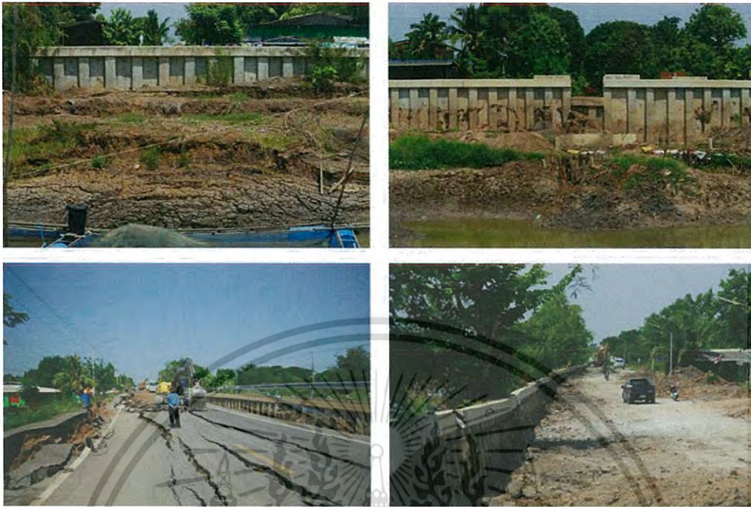
รูปที่ 2.2-5 การพิบัติของลาดตลิ่งด้านหน้ากำแพงเนื่องจากน้ำลดลงต่ำมาก ส่งผลให้กำแพงเคลื่อนตัวตาม เพราะสูญเสียแรงดันด้านหน้า
