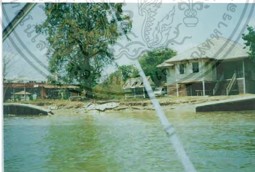
รูปที่ 2.3.11 การพิบัติของตลิ่งแม่น้ำบางปะกง (GERD)
