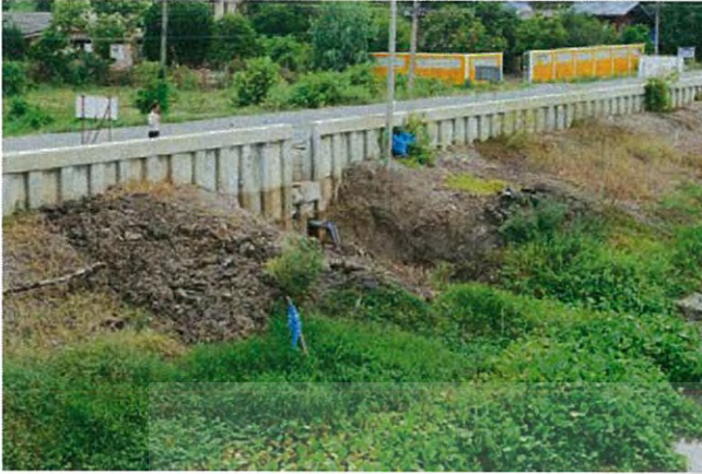
รูปที่ 2.2-6 การขุดปรับลาดตลิ่งเพื่อสูบน้ำของเกษตรกร
