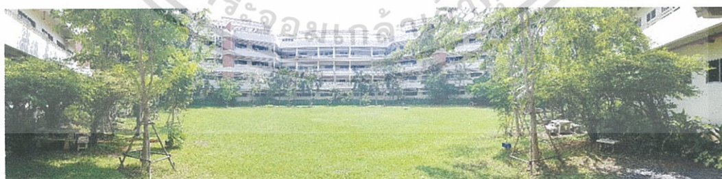
รูปที่ 1.3 ลานกลางอาคารเจ้าคุณทหาร
