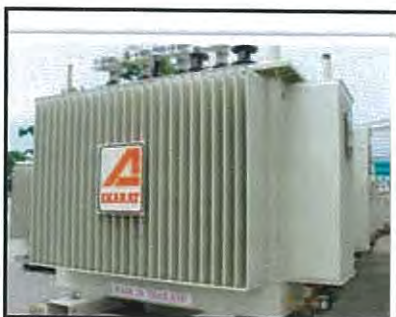
รูปที่ 2.26 ครีบหม้อแปลงแบบลอนลูกฟูก
