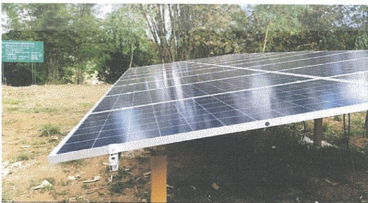
รูปที่ 4.2 การติดตั้งแผงโซล่าเซลล์ในพื้นที่
