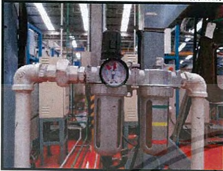
Visual แสดงระดับน้ำมันและมาตรวัดแรงดัน
