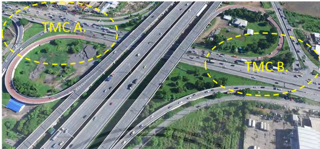
TMC A. คือ ตำแหน่งสัญญาณไฟจราจรบริเวณทางหลวงหมายเลข 3312 (ถ.ลำลูกกา) ฝั่งตอนเมือง TMC B. คือ ตำแหน่งสัญญาณไฟจราจรบริเวณทางหลวงหมายเลข 3312 (ถ.ลำลูกกา) ฝั่งลำลูกกา
