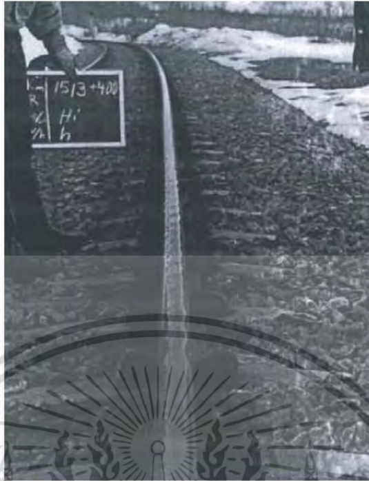
รูปที่ 3.24 ผีวรางเป็นลูกฟูก [15]
