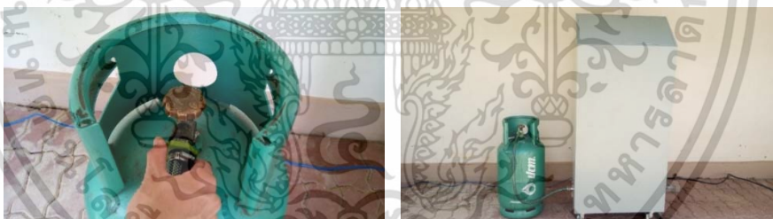
รูปที่ 3.14 การติดตั้งหัวจ่ายก๊าซเข้ากับถังก๊าซหุงต้ม
