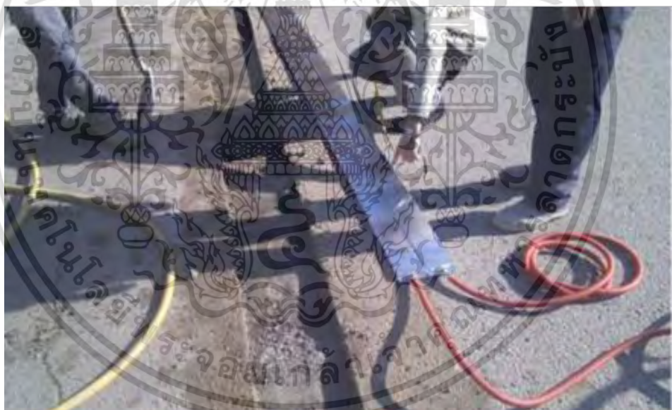
รูปที่ 1.3 ลักษณะการติดตั้งวัสดุเพียโซอิเล็กทริกที่พื้นถนน
