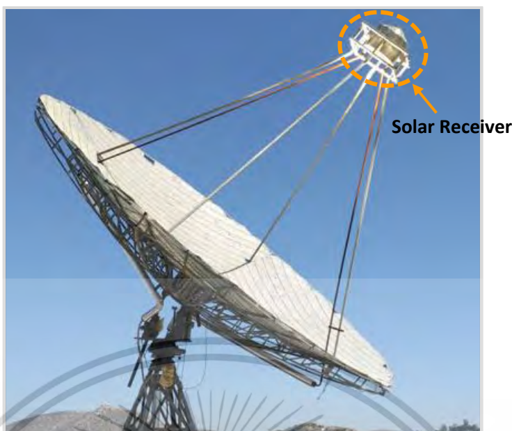
รูปที่ 1.2 แสดงระบบจานรวมแสงอาทิตย์พาราโบลิค กับตัวรับแสงอาทิตย์
