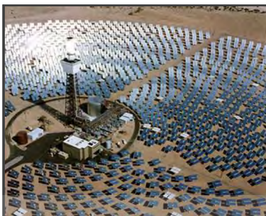
รูปที่ 3.6 โรงไฟฟ้าแบบหอคอยพลังงาน ที่เมืองบาร์สโรว์ ในรัฐแคลิฟอร์เนีย สหรัฐอเมริกา
