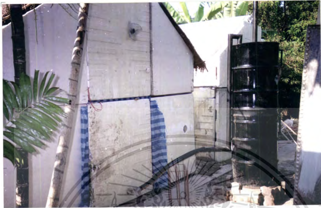
ภาพที่ 1 แสดงการต่อเครื่องกำเนิดน้ำเข้าโรงเรียน
