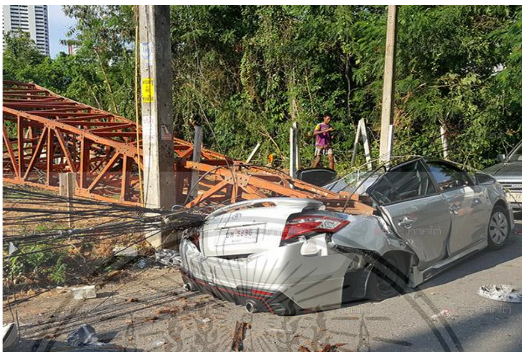
ภาพที่ 1.1 ตัวอย่างความเสียหายที่เกิดจากการทำงานของปั้นจั่นตอกเสาเข็ม
