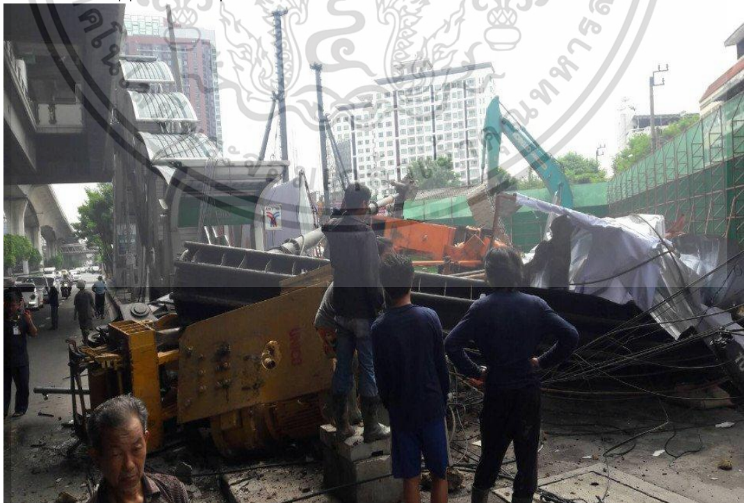
ภาพที่ 2.10 อุบัติเหตุปั้นจั่นตอกเสาเข็มล้มทับสายไฟขวางถนน 1 เลน เอกสารนี้เป็นเอกสารที่สงวนไว้สำหรับกรใช้งานเพื่อการศึกษาเท่านั้น เมื่ออนุญาตให้นำไปใช้ประโยชน์ด้านการค้า ไม่ว่ากรณีใดๆ ทั้งสิ้น อีกทั้งห้ามมิให้ดัดแปลงเนื้อหา และต้องอ้างอิงถึงเจ้าของเอกสารทุกครั้งที่มีการนำไปใช้
