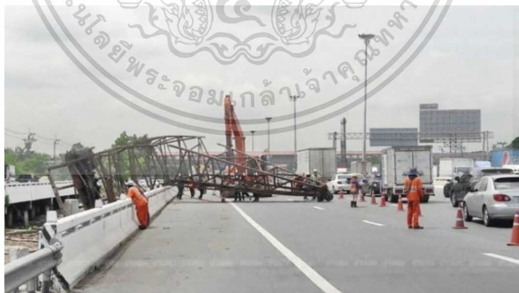
ภาพที่ 2.12 อุบัติเหตุปั่นจั่นตอกเสาเข็มล้มทับถนนกาญจนาภิเษก
