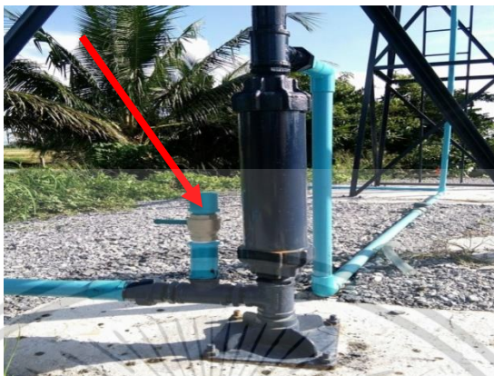
รูปที่ 6.12 ช่องสำหรับใส่น้ำ หลังจากประกอบส่วนต่างๆเสร็จแล้ว เพื่อให้กังหันลมทำงาน
