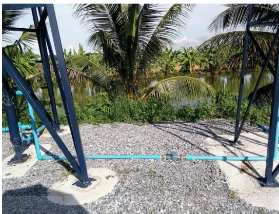
รูปที่ 6.5 Flow meter ที่ติดตั้งไว้ที่ท่อส่งน้ำระหว่างกังหันลมและถังเก็บน้ำ
