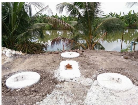
รูปที่ 6.2 ตำแหน่งการวางฐานเสาเข็มสำหรับยึดเสาแก้งัดน้ำ
