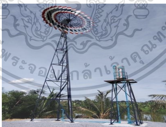
รูปที่ 6.4 แสดงส่วนประกอบของเสาโครงสร้างแก้งัดน้ำและถังเก็บน้ำที่ประกอบเสร็จเรียบร้อยแล้ว
